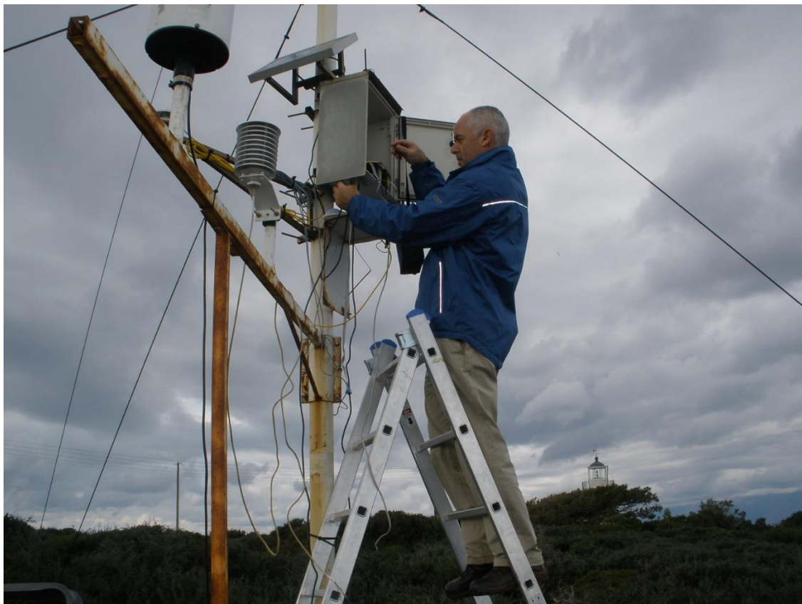
Εικόνα 1: Απο τις τεχνικές εργασίες στον κεντρικό κλωβό του σταθμού ΖΚΤ-3.
