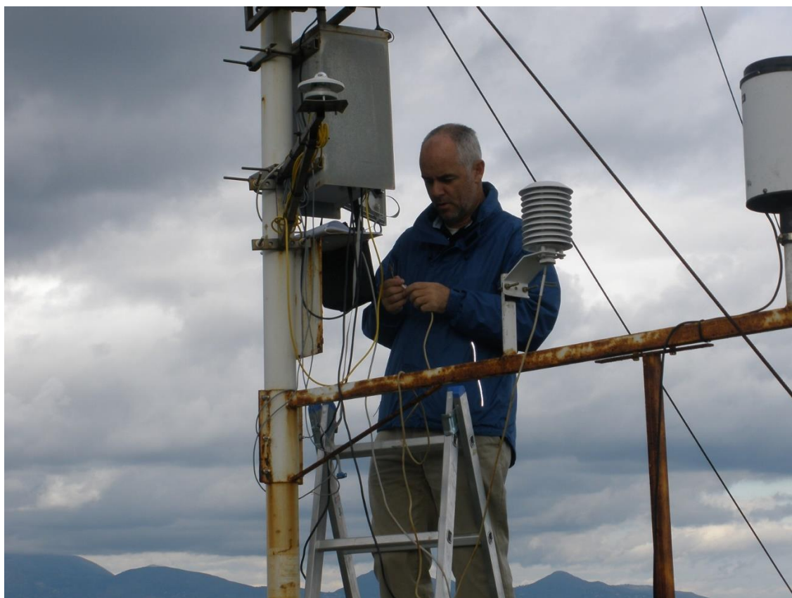
Εικόνα 2: Απο τις εργασίες αντικατάστασης και αναδιάταξης καλωδιώσεων στον ΖΚΤ-3.
